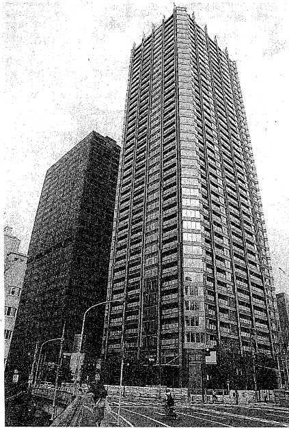
高層ビルや建設中のマンションが並ぶ北浜周辺(写真上、大阪市)と、高齢者が増え、店頭の目立つ場所に手押し車が並ぶ玩具店(同下、兵庫県川西市)
