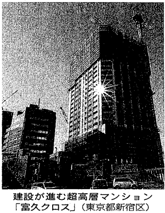
建設が進む超高層マンション「富久クロス」(東京都新宿区)
